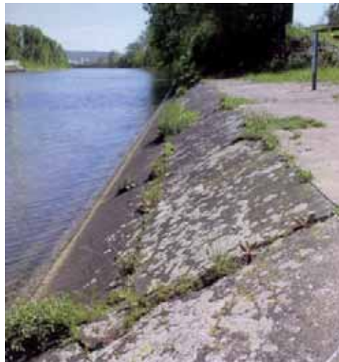
Betoniertes Neckarufer
